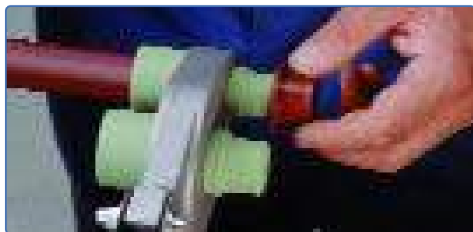
Fusione el buje al tubo.
