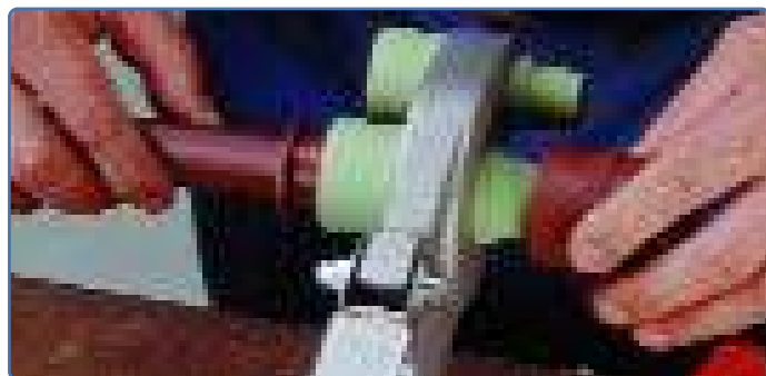
Transcurrido un minuto, fusione el conjunto, tubo-buje, a la conexión.
