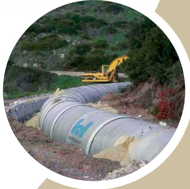
Al no instalar los tubos en línea recta, sino con un cierto ángulo, se produce automáticamente una separación en la copla. Esto no supone ningún problema en sistemas de transporte gravitacional. Sin embargo, en las conducciones que se instalan en centrales hidroeléctricas es importante evitar cualquier pérdida. Con el sistema HOBAS de corte en diagonal se evita la separación en la copla y se obtienen unas condiciones hidráulicas excelentes, con lo que se evita el uso de accesorios caros.
